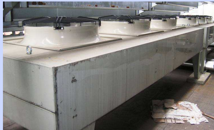
GF condensato ad aria
